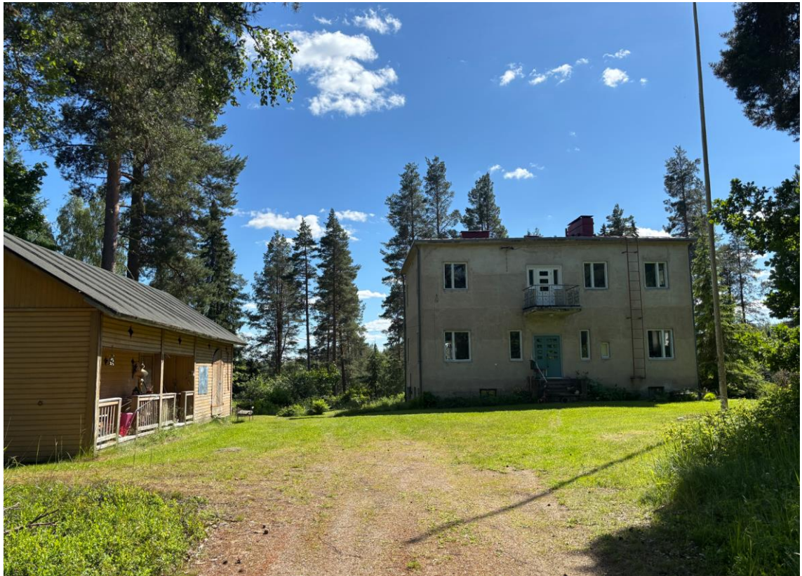
Kuva 27. Vuollemäen rapattu rakennus.
