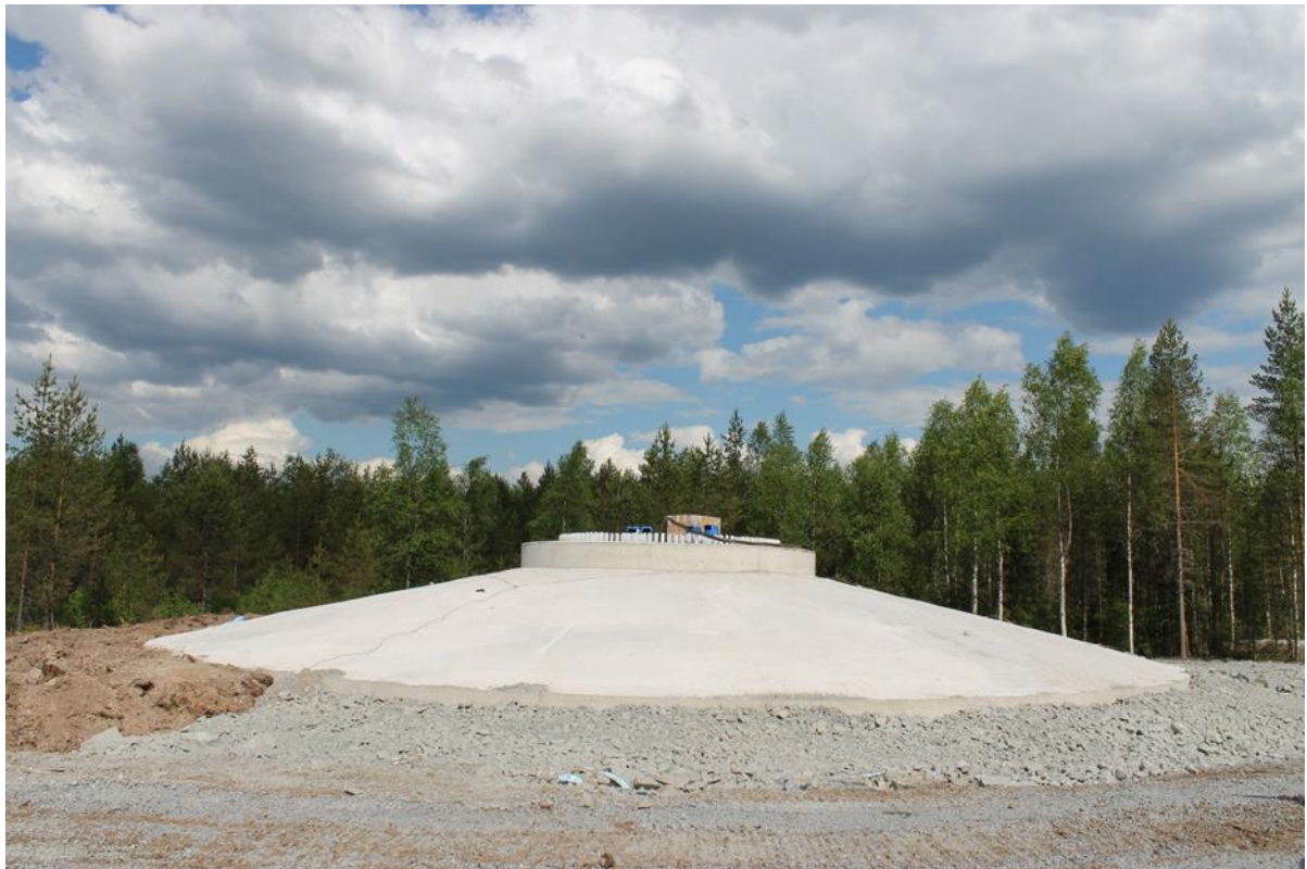
Kuva 7-4. Esimerkkikuva tuulivoimalan teräsbetoniperustuksesta, Silovuoren tuulivoimapuisto Pyhäjoella (Kuva: ABO Energy Suomi Oy).
