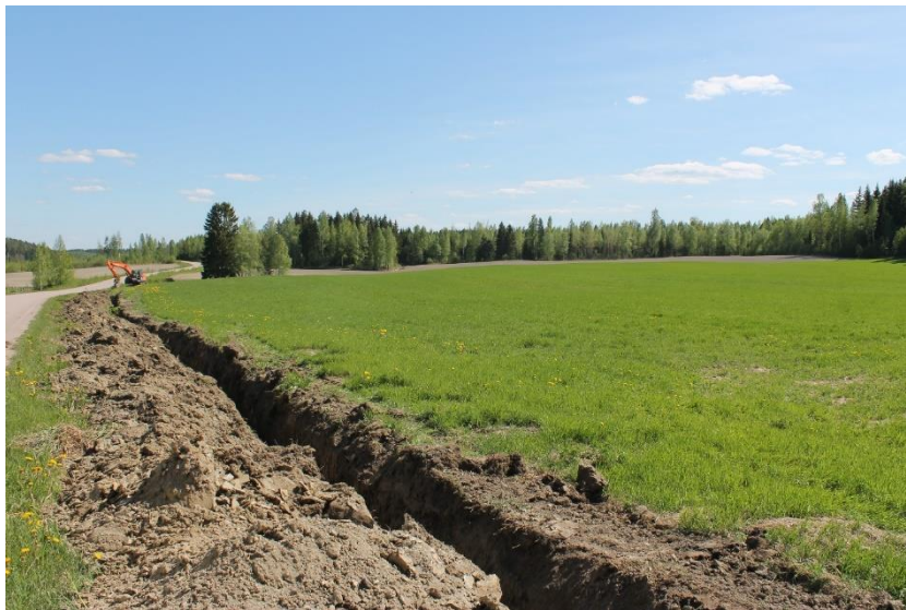
Kuva 7-10. Esimerkkikuva maakaapelin kaapeliojan kaivuutyöstä, Ratiperän tuulivoimapuisto Jämsällä (Kuva: ABO Energy Suomi Oy).
