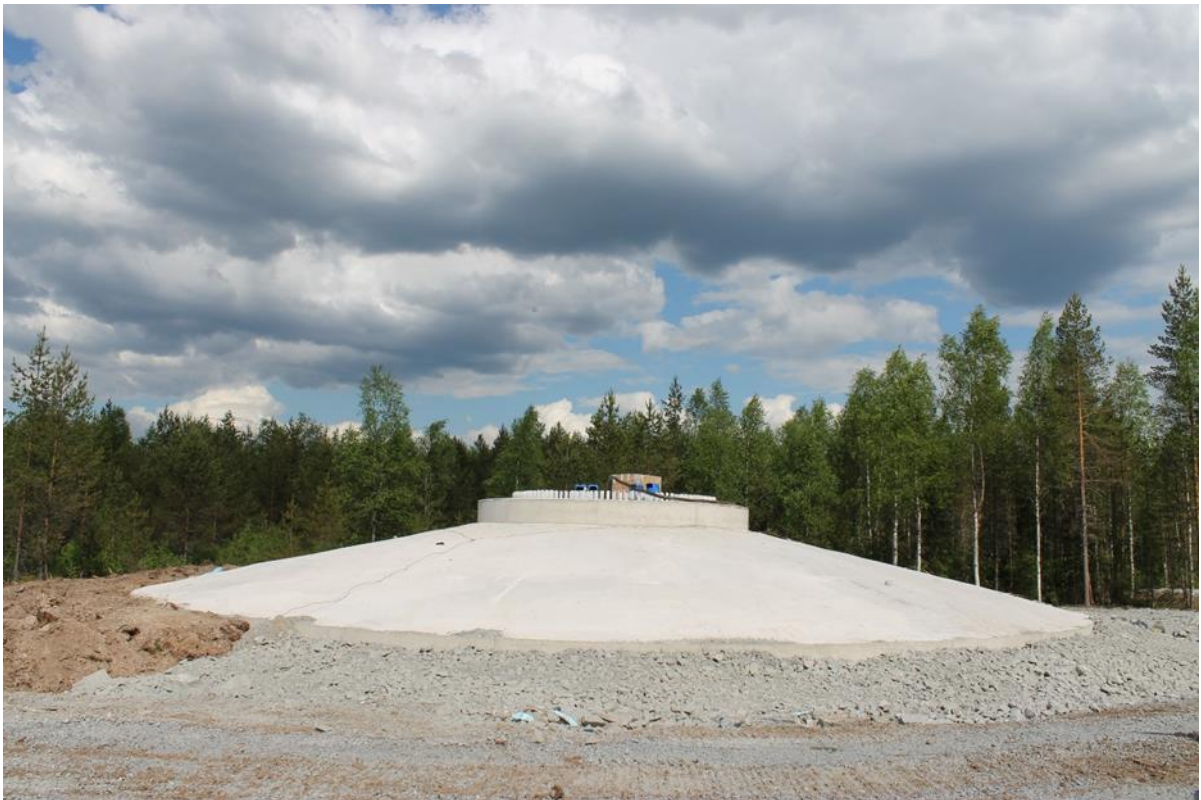
Kuva 7-4. Esimerkkikuva tuulivoimalan teräsbetoniperustuksesta, Silovuoren tuulivoimapuisto Pyhäjoella (Kuva: ABO Wind Oy).
