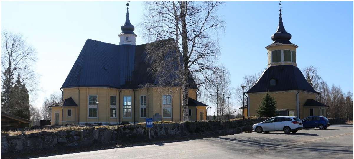
Kuva 4-12. Ruoveden kirkko on 24-kulmainen ristikirkko, joka on rakennettu vuosina 1777–1778.
