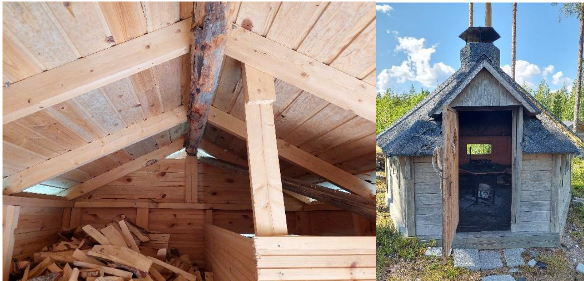
Kuva 3-5. Tarkastetut rakennukset, joista puuvarastorakennus ja kota.
