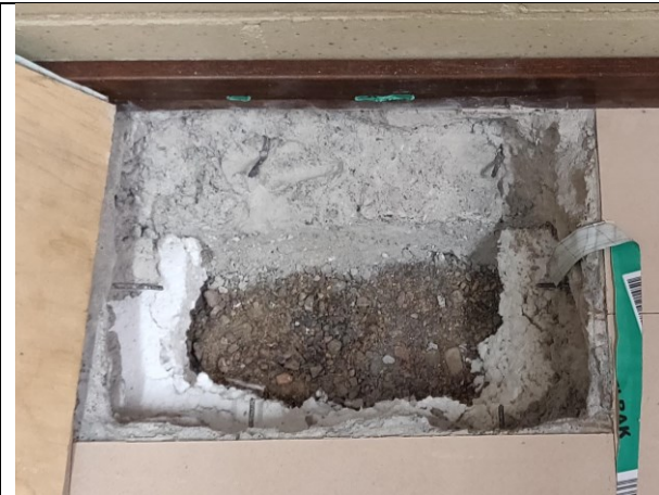
Rakenneavaus, Sali. Laatan alla 50mm eps eriste, väliseinä lähtee anturan päältä. Hiekkatäyttö on kostea.
