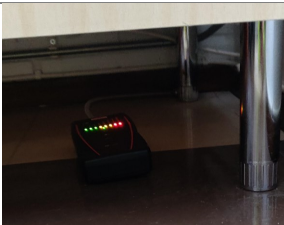
Merkkiaine vuotaa ulkoseinärakenteesta
