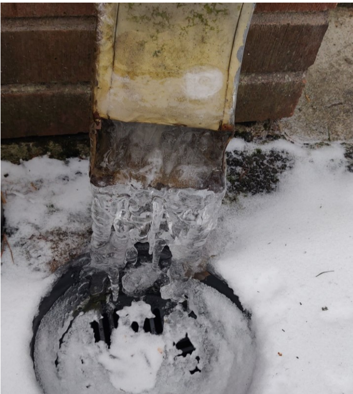
Syöksytorvissa ei ole sulanapitoa, jäätyvät tukkoon talvella
