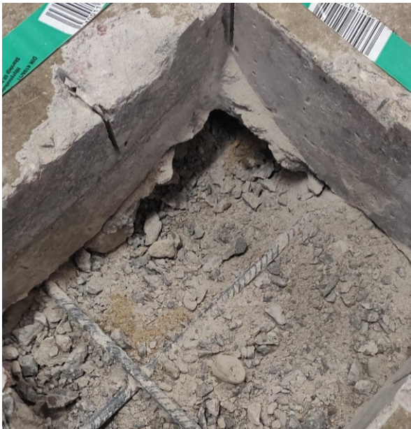
Raudoitukset ovat osin laatan alapuolella
