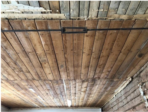
hirsikehikon vaurioita ja seinien oikomiseen asennettu vantti
