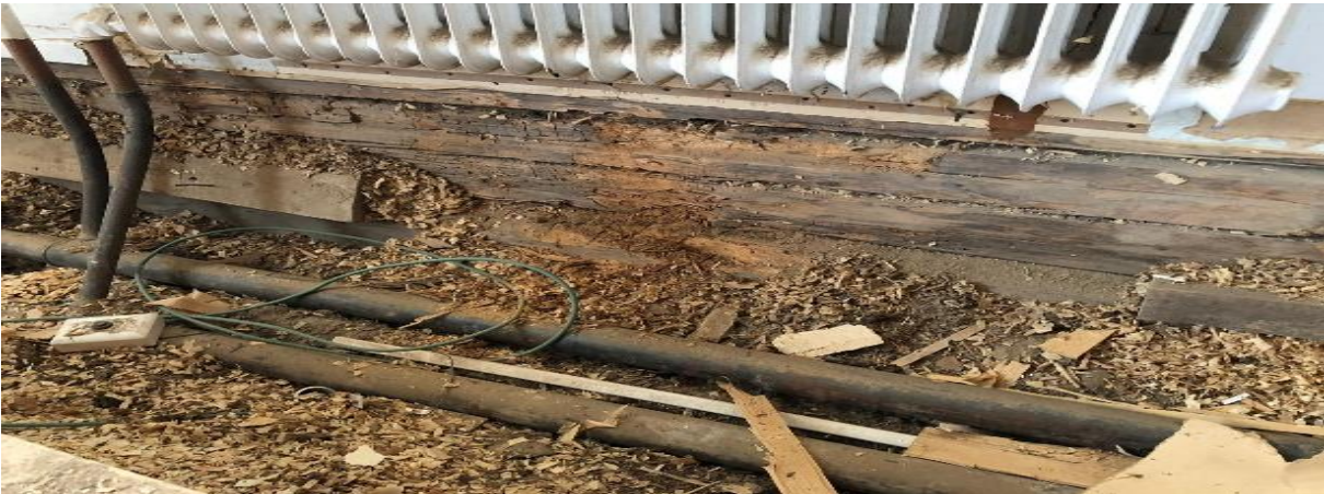
hirsikehikon vaurioita ja seinien oikomiseen asennettu vantti
