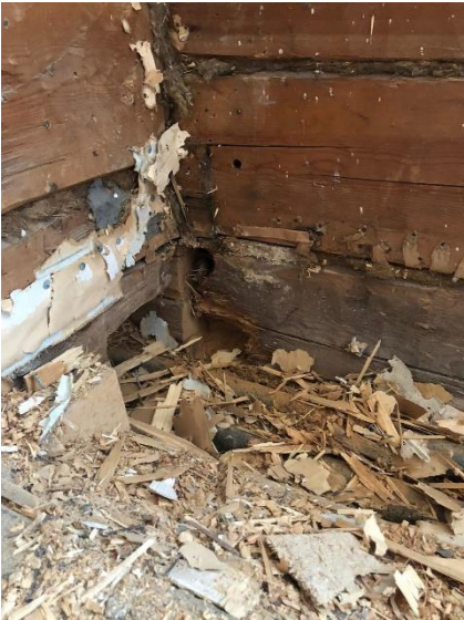
hirsikehikon vaurioita ja seinien oikomiseen asennettu vantti
