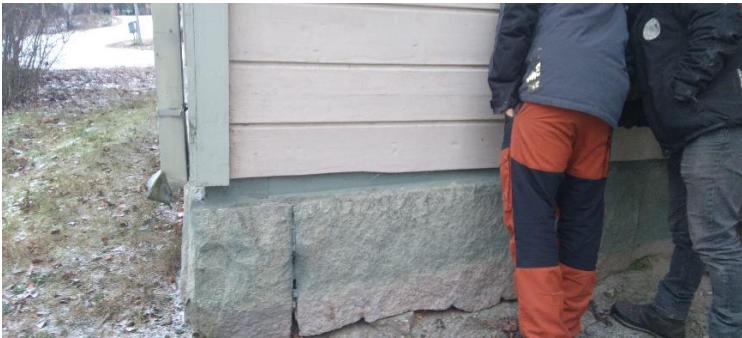
idänpuoleisen kuistin pudonneen perustuksen betonikorjaus
