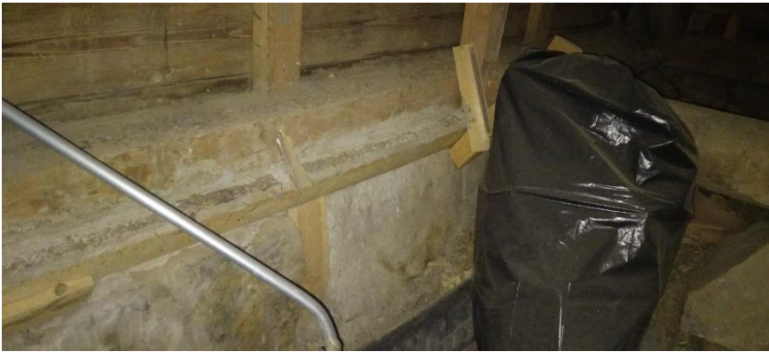
idänpuoleisen kuistin betonilla ympäröity alajuoksu
