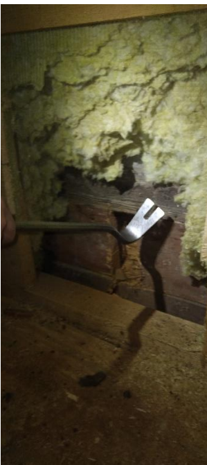
käytävän alueelta katkaistun hirsiväliseinän alaosa.
