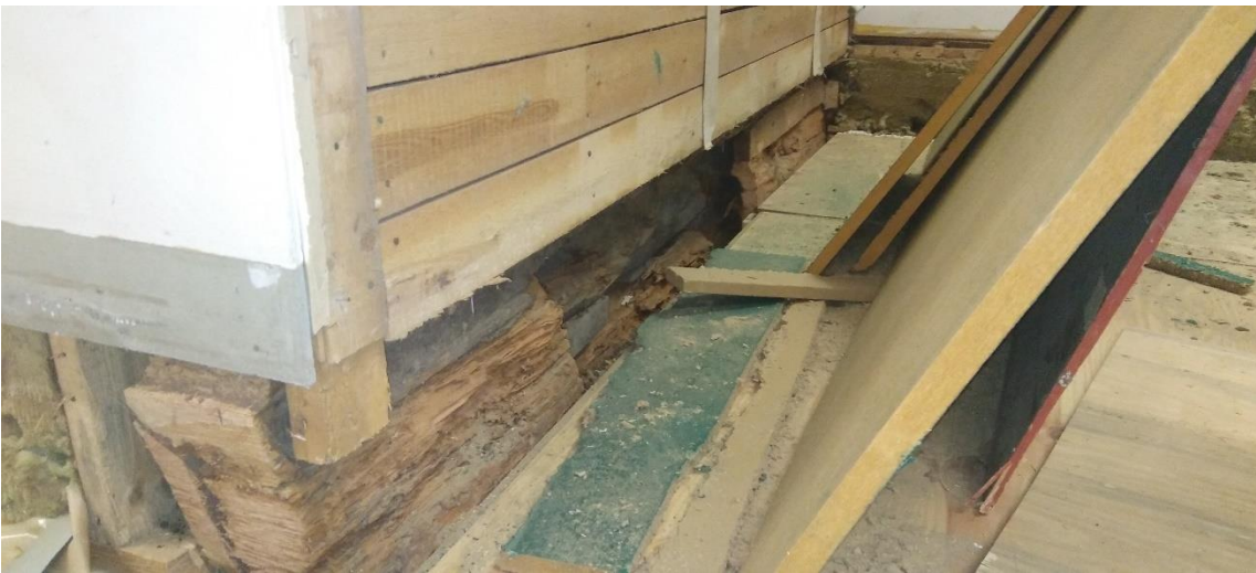
käytävän alueelta katkaistun hirsiväliseinän alaosa.
