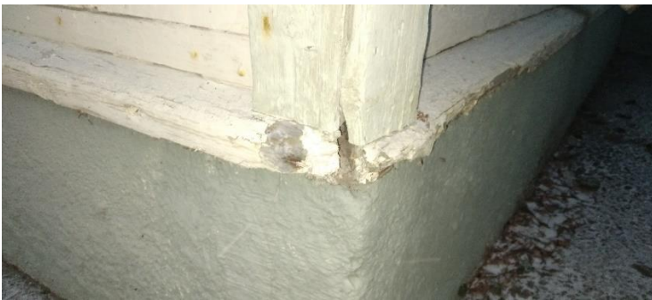
idänpuoleisen kuistin betonilla ympäröity alajuoksu
