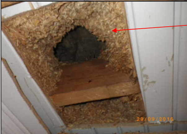
Kuva 3. Rakenteenavaus yläkerran katosta, yläpohjan purua.
