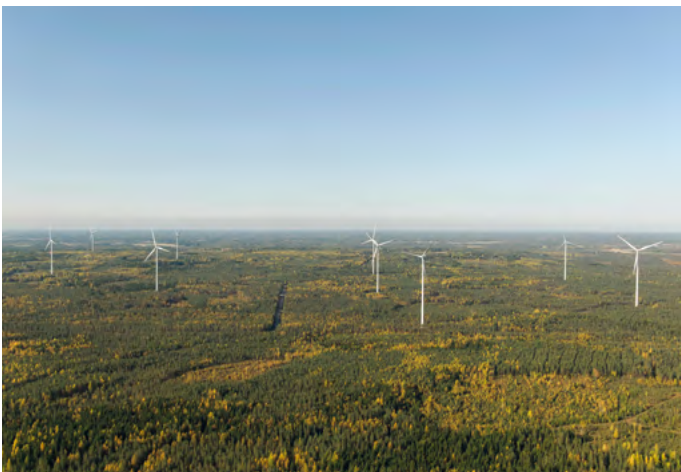
Haapajärven kaksi ensimmäistä voimalaa rakennettiin 2015 ja loput seitsemän vuonna 2017.
