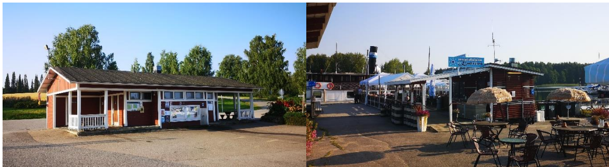
Kuva 7. Vasemmalla veneilijöiden huoltorakennus ja oikealla grillirakennus.
